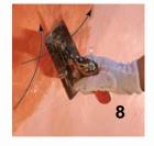
шпатель к поверхности под острым углом краем, на котором находится материал. (фото 8) Держа шпатель под таким же острым углом повторными разнонаправленными «прижимно/ сдвигающими» движениями втирают материал в поверхность. Материал, налипающий на инструмент периодически собирают на плоскости шпателя ближе к рабочей грани и вновь наносят на поверхность.
