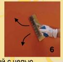
Нанесение финишного слоя и полировка. Нанесение финишного слоя является наиболее ответственным этапом, проявляющим фактуру (т.е. декоративный вид всего покрытия в целом). Финишный слой наносится короткими разнонаправленными мазками небольшими участками площадью 0,5-1,0 м2. На тыльную сторону трапецеидального «шпателя» наносятся небольшие количества VENETO CLASSICO, которые затем распределяются по площади короткими разнонаправленными поступательными движениями, прижимая
