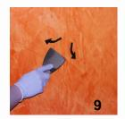
Сразу же не давая материалу высохнуть приступить к полировке участка поверхности разнонаправленными движениями трапецеидального шпателя. (фото 10) Следует помнить, что на этапе полировки шпатель должен прижиматься к поверхности под острым углом именно гранью, а не всей плоскостью целиком. Усилие прижатия шпателя к поверхности с каждым
